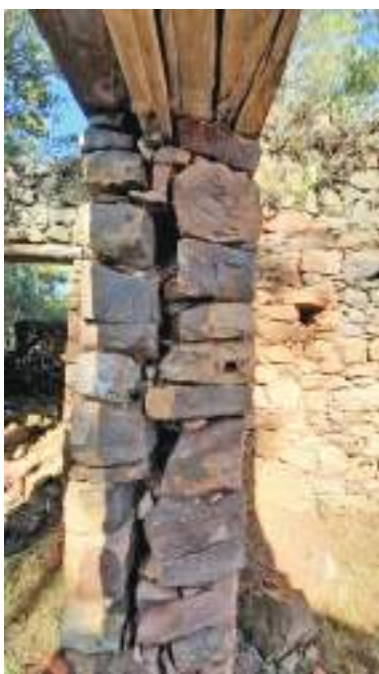
Pared interior con dintel correspondiente asegurando la apertura del vano.
