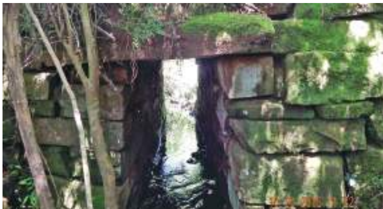
Alcantarilla en las puntas del Cuñapirí.
