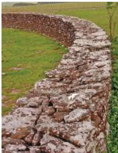
Vista parcial de la manguera existente en San Juan Bautista, BR.
