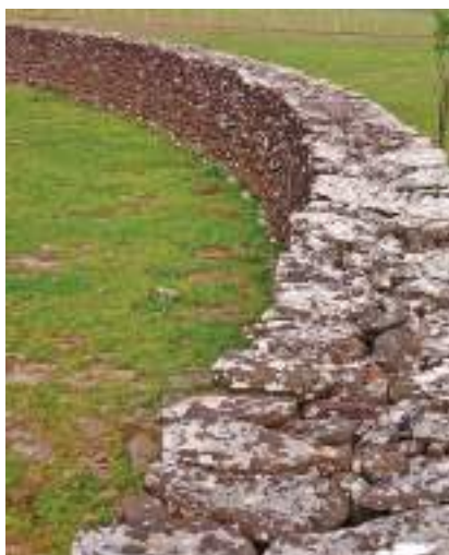
Muro de una Manguera.
