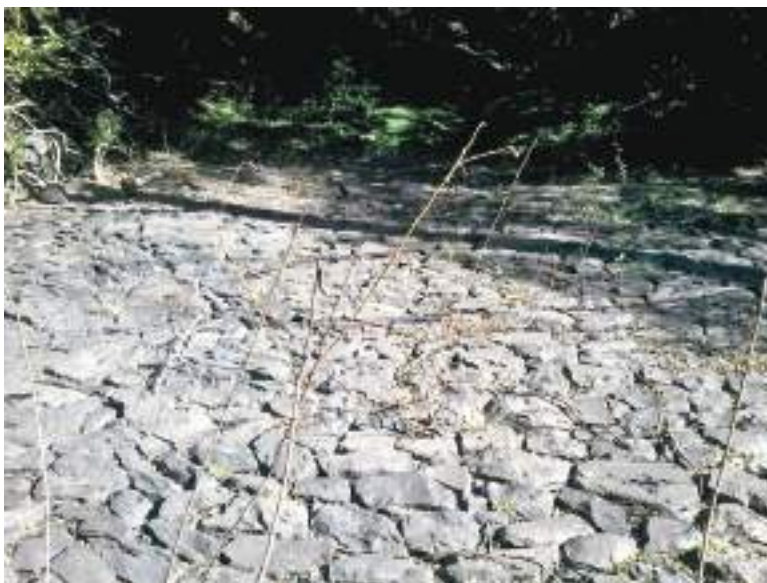
Calzada sobre el arroyo Corrales.
