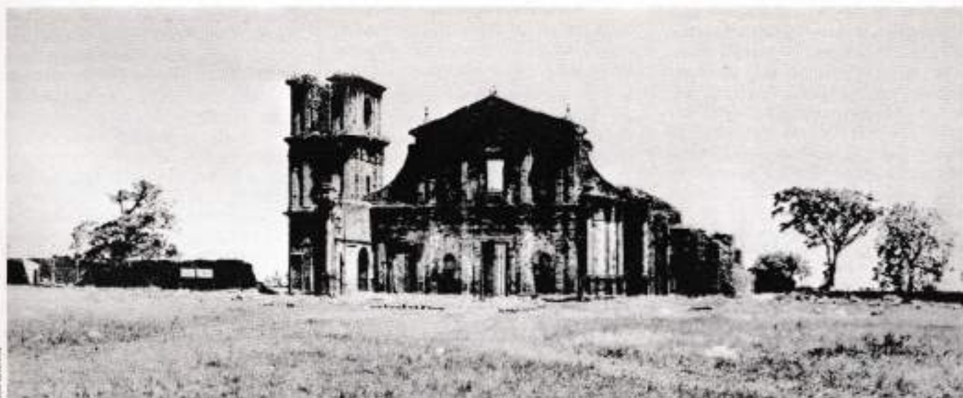
Fachada das ruínas da igreja de São Miguel das Missões; como estava o monumento, antes das obras atuais, iniciadas em outubro de 1982.
