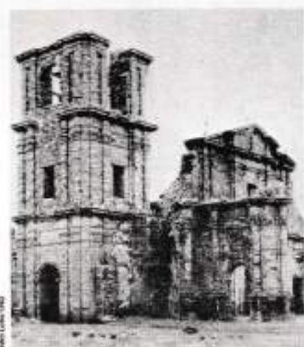
Igreja, torre e pórtico: épocas diferentes de construção.
