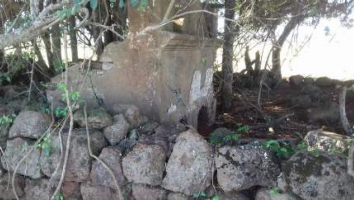
Figura 57 – Estrutura da Capela de São Jeronimo encontrada no interior de São Nicolau
