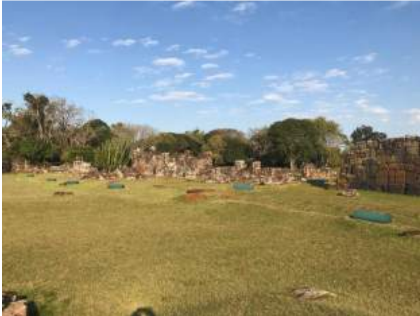
Foto 3 – Vista da área passível de recuperação
