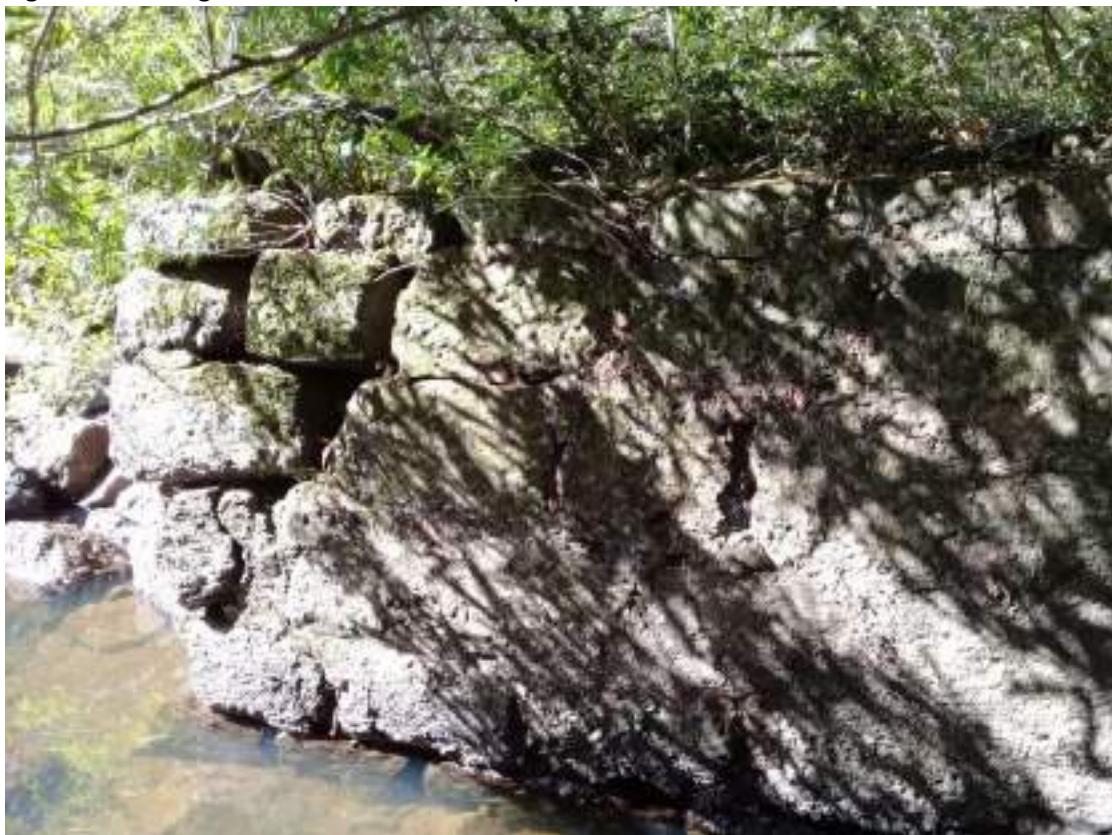
Figura 37 – Fotografia com a estrutura em pedras existente no local
