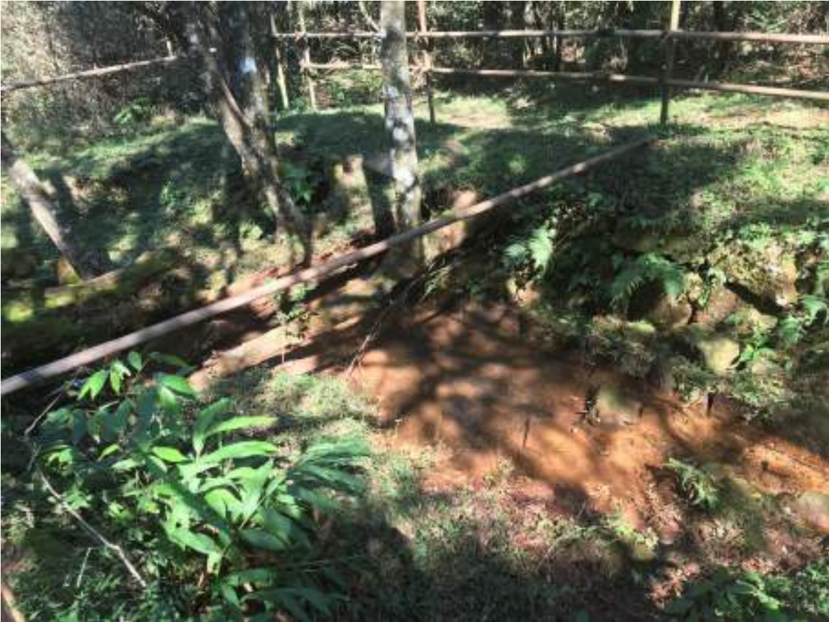
Figura 31 – Segunda fonte que teve apenas as escavações iniciais
