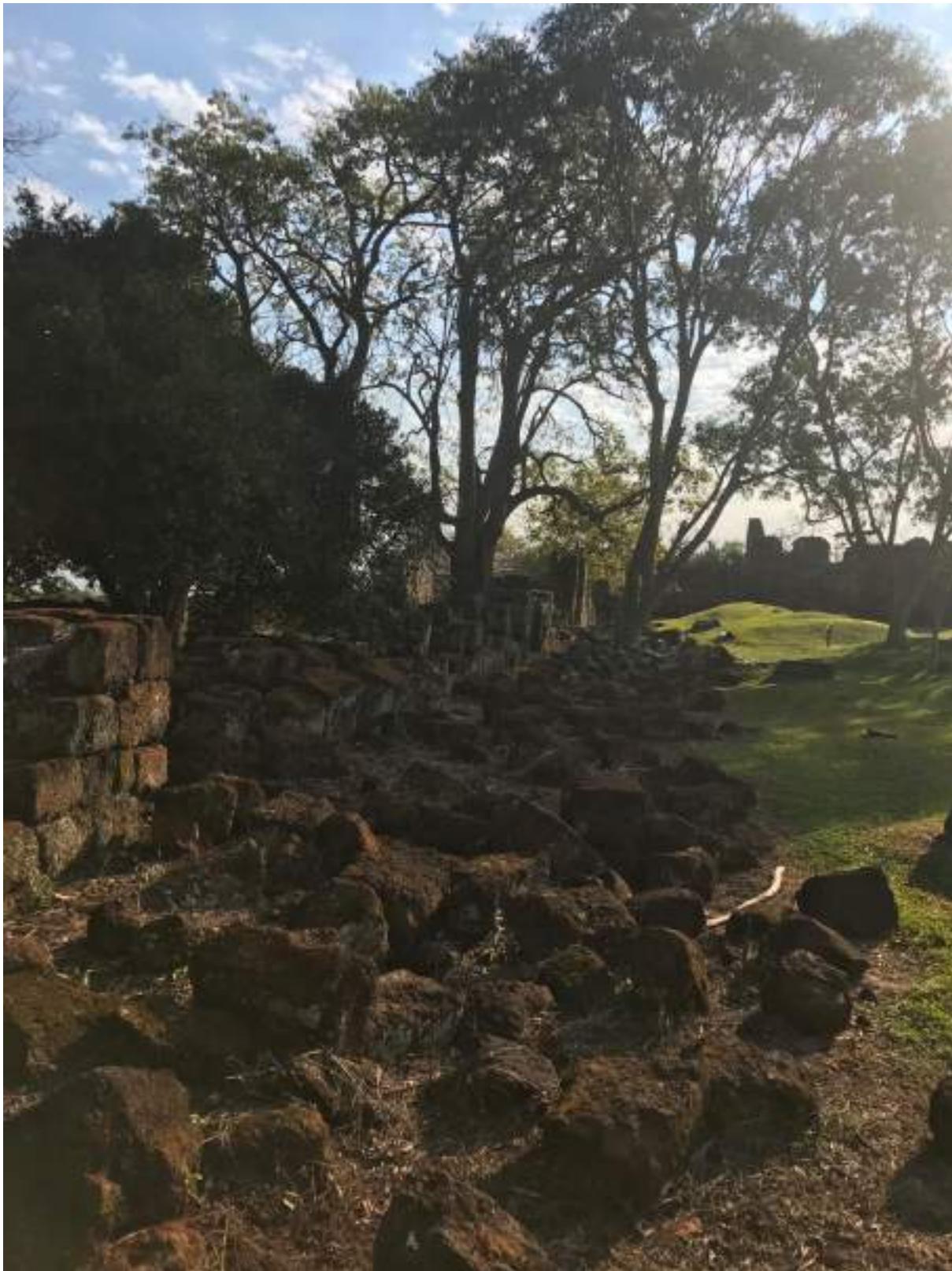
Foto 10 - Exemplo das estruturas que são passíveis de recuperação
