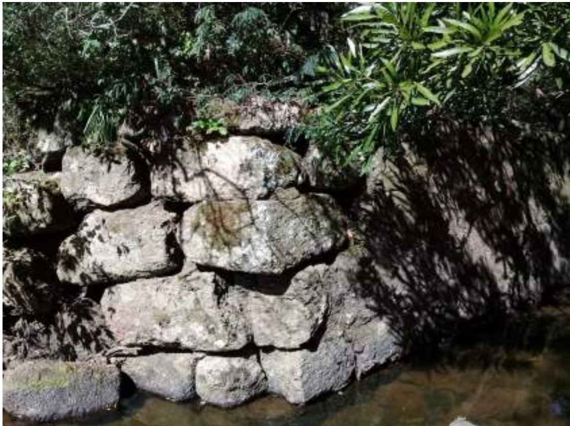
Figura 36 – Fotografia com a estrutura em pedras existente no local
