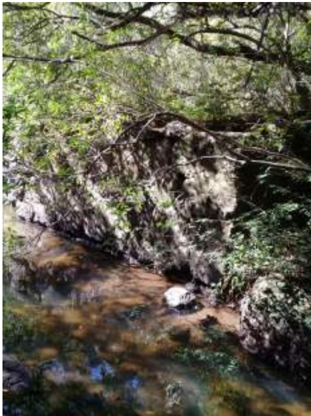
Figura 34 – Fotografia com a estrutura em pedras existente no local
