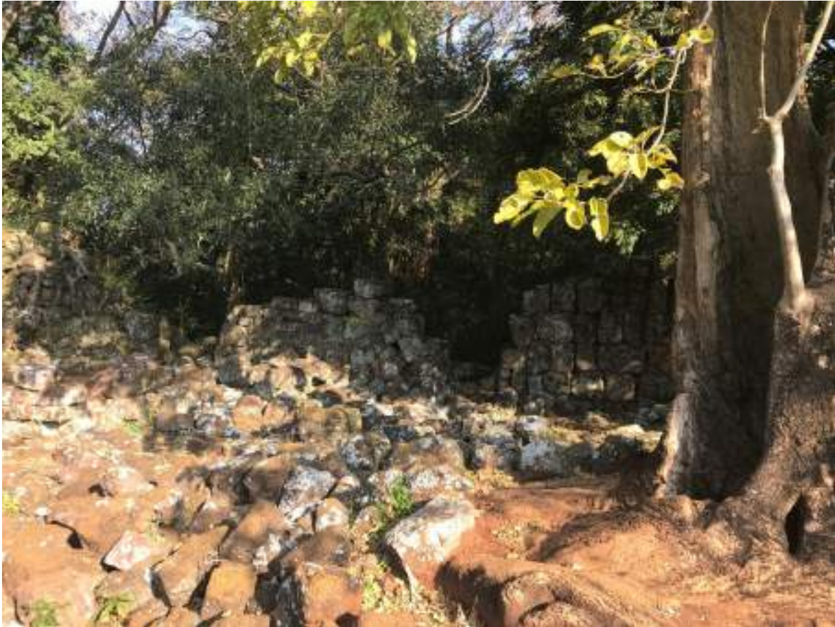
Foto 8 - Exemplo das estruturas que são passíveis de recuperação
