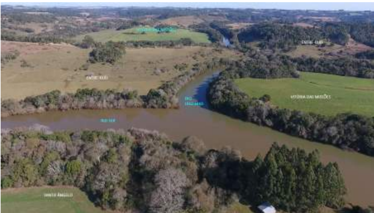
Figura 67 – Local onde foi instalada a primeira redução de Santo Ângelo
