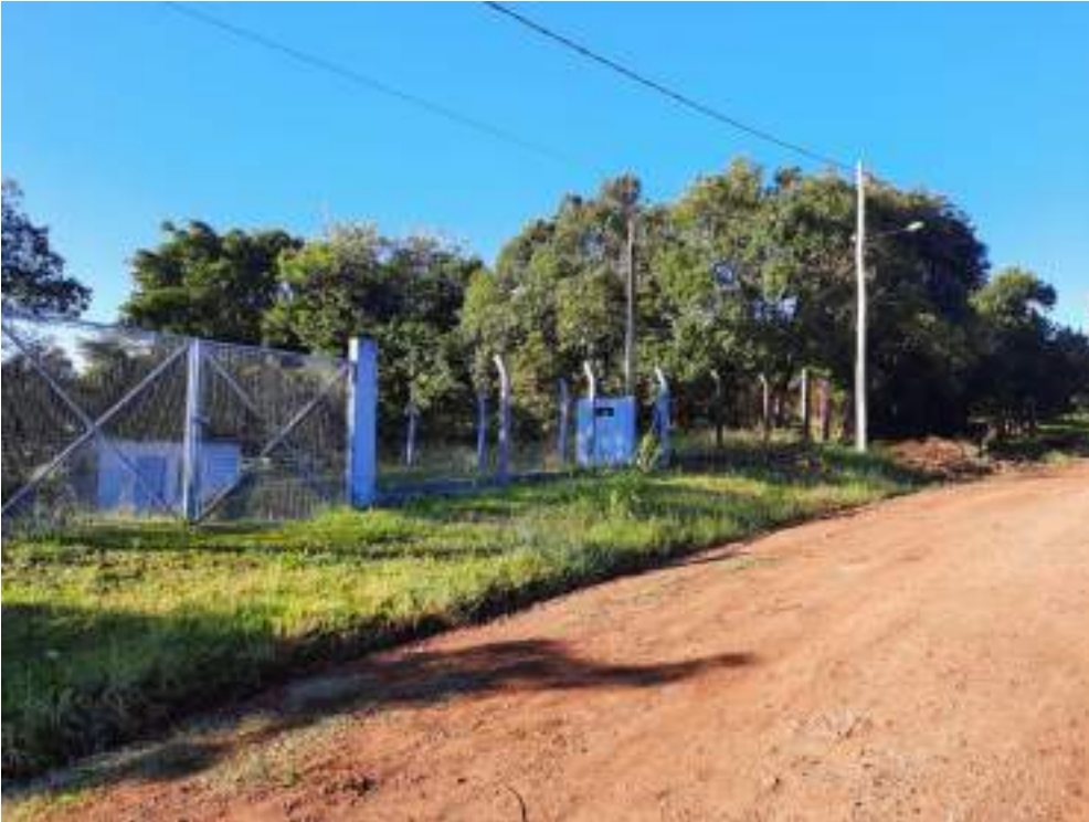
Figura 26 – Vista da rua onde se localiza o Chafariz
