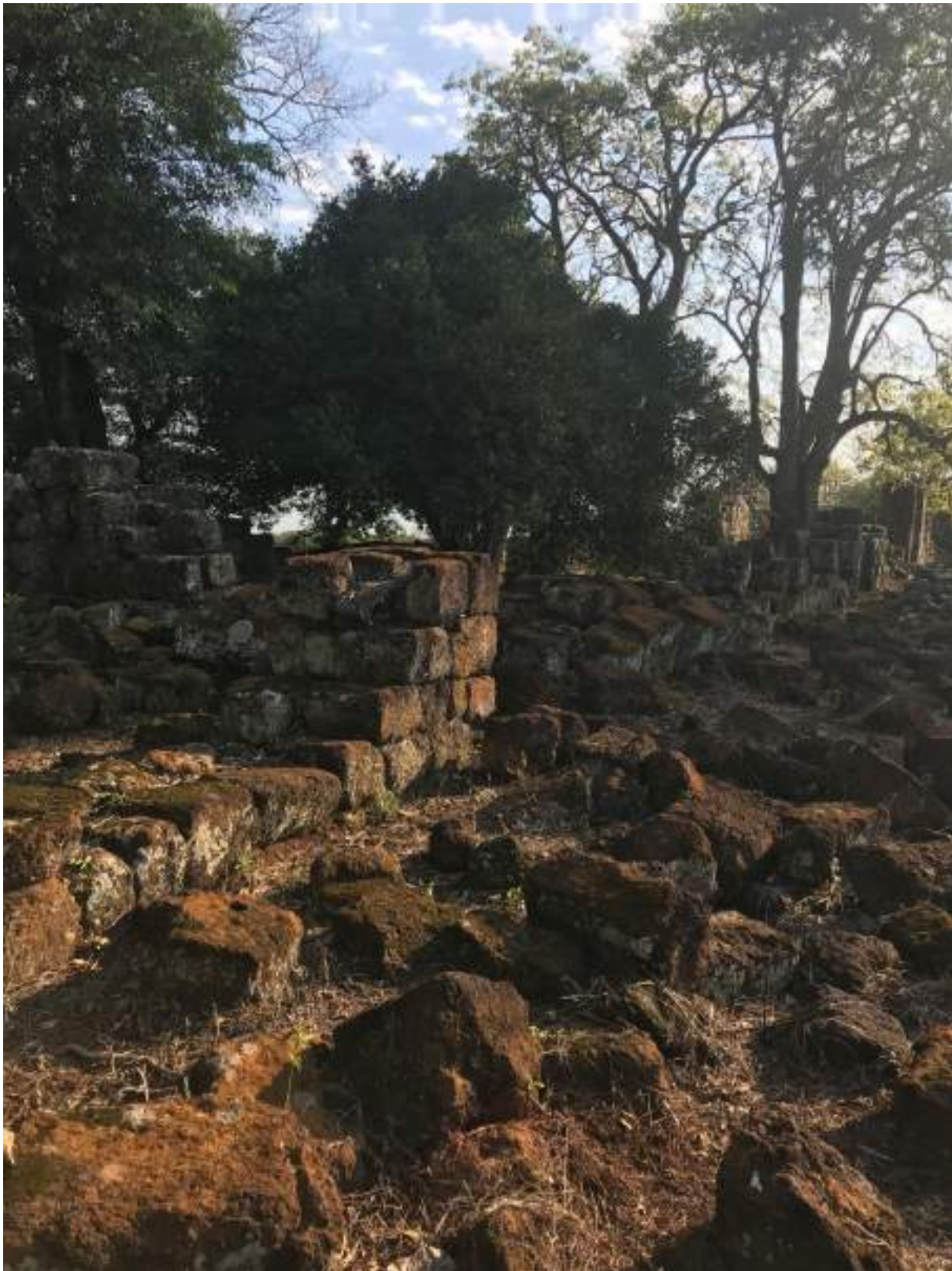
Foto 7 – Exemplo das estruturas que são passíveis de recuperação
