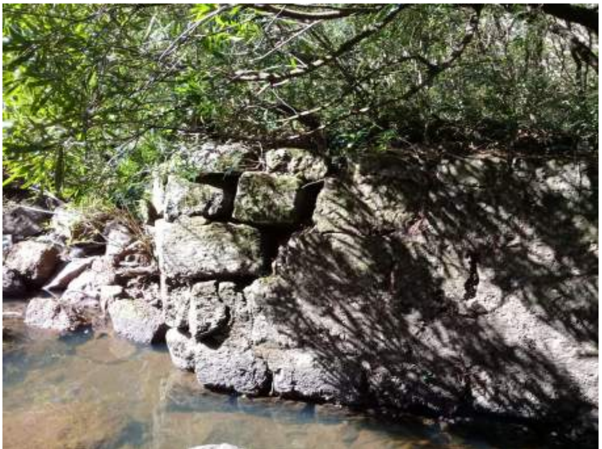
Figura 35 – Fotografia com a estrutura em pedras existente no local
