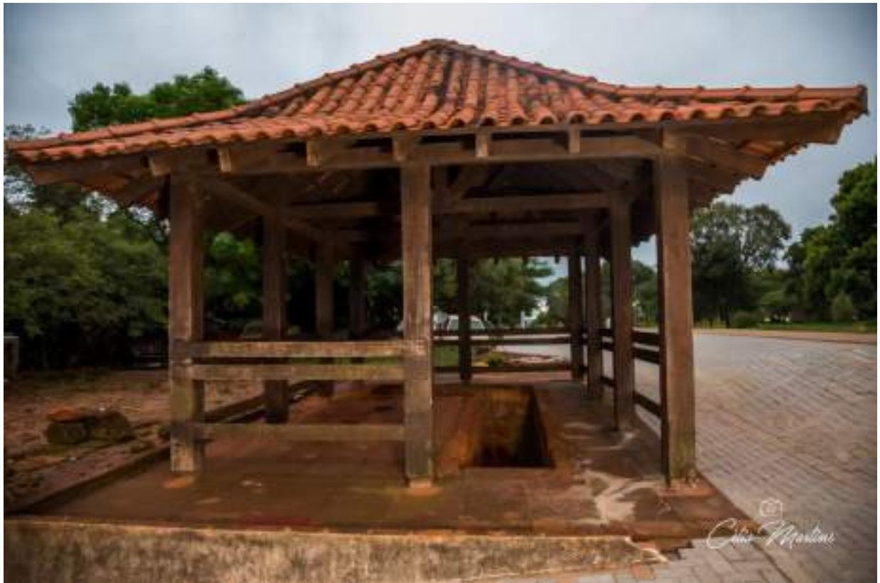
Figura 60 – Lado externo da entrada da adega
