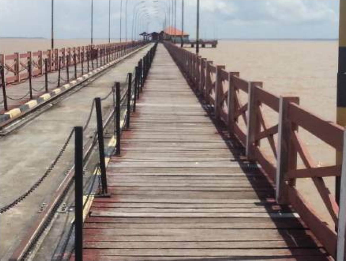
Figura 50 – Exemplo de passarela sobre o rio
