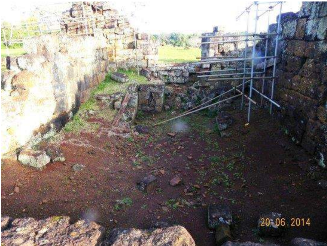
Foto 11 – Estágio atual da instalação do que foi a adega dos padres
