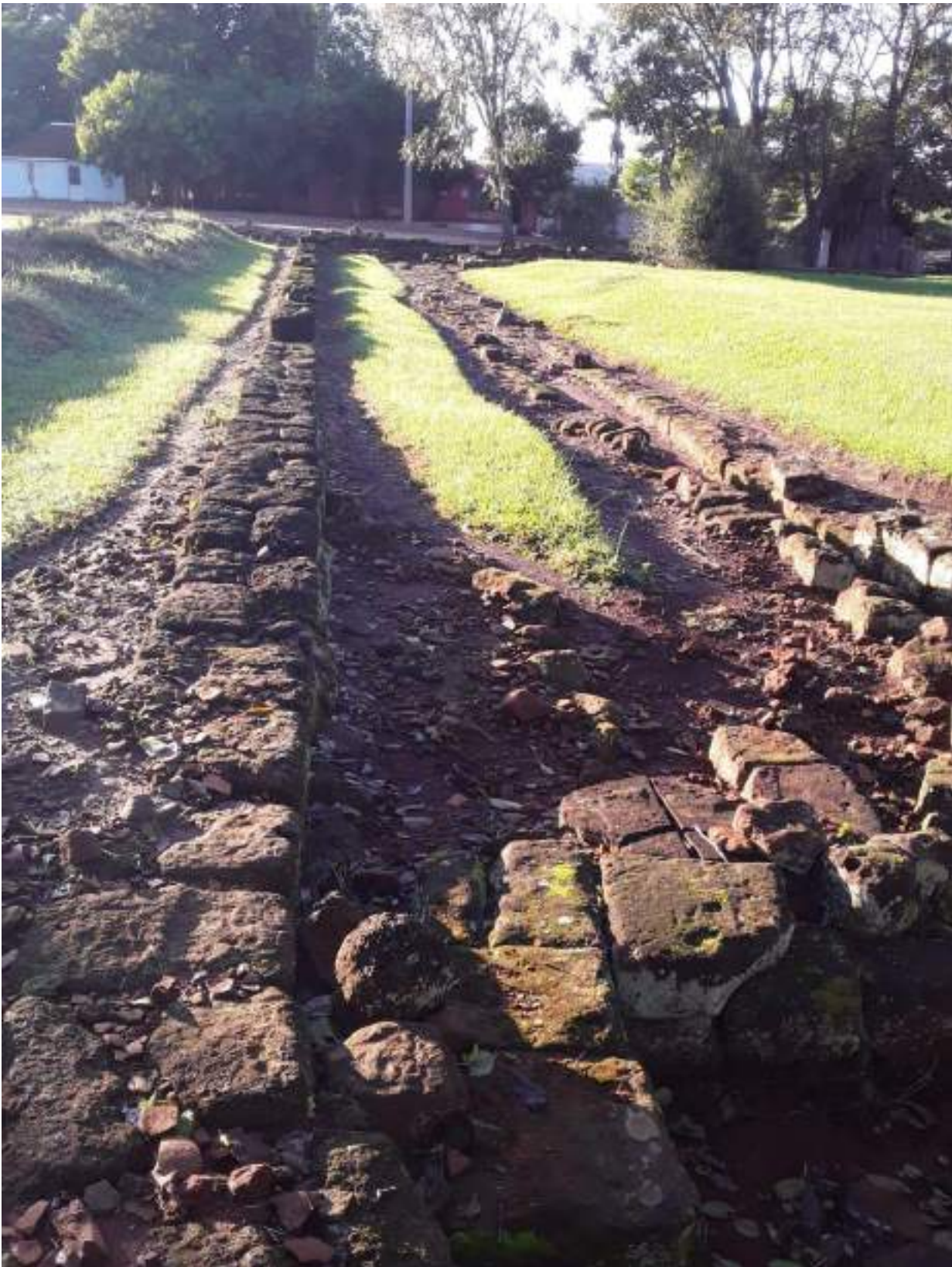
Figura 29 – Canalizações do sistema hídrico- sanitário
