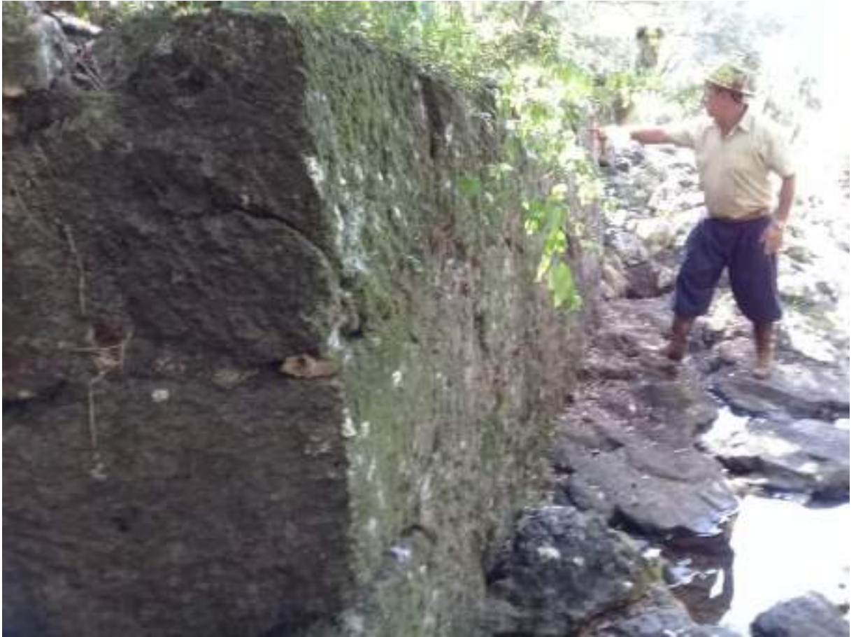
Figura 38 – Fotografia com a estrutura em pedras existente no local
