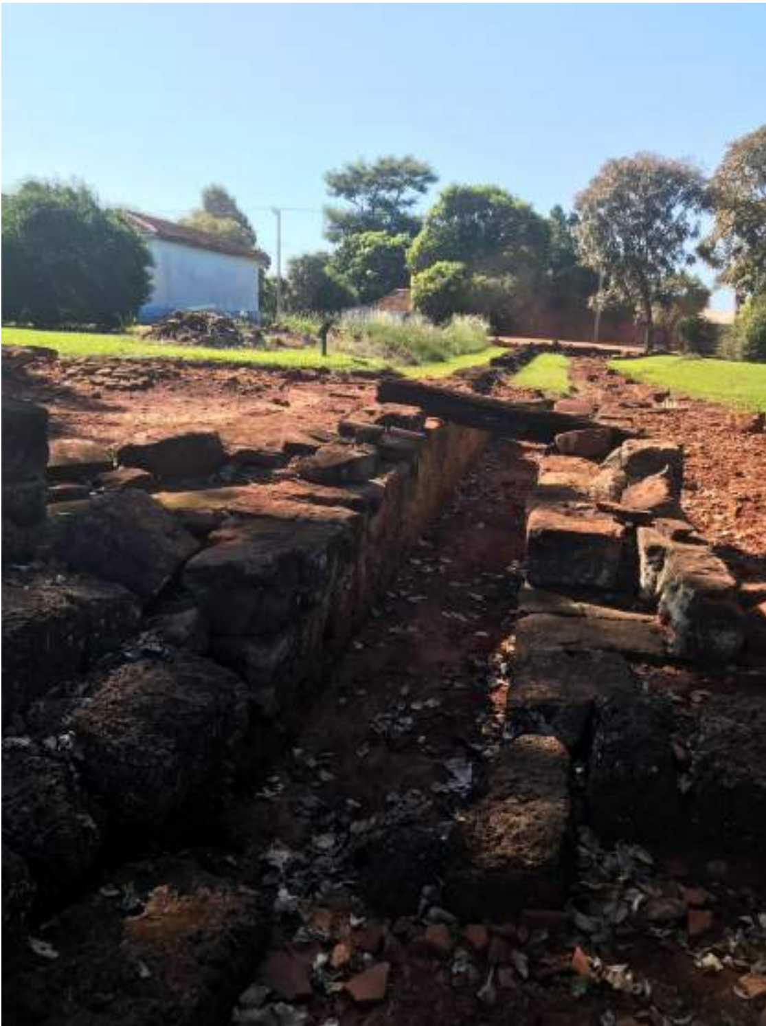
Figura 28 – Canalizações que compunham o sistema hídrico- sanitário da Redução
