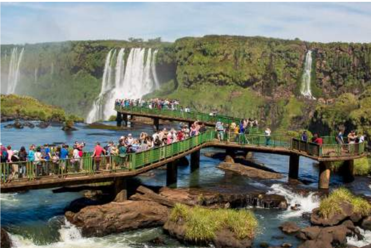
Figura 51 – Exemplo de passarela sobre o rio
