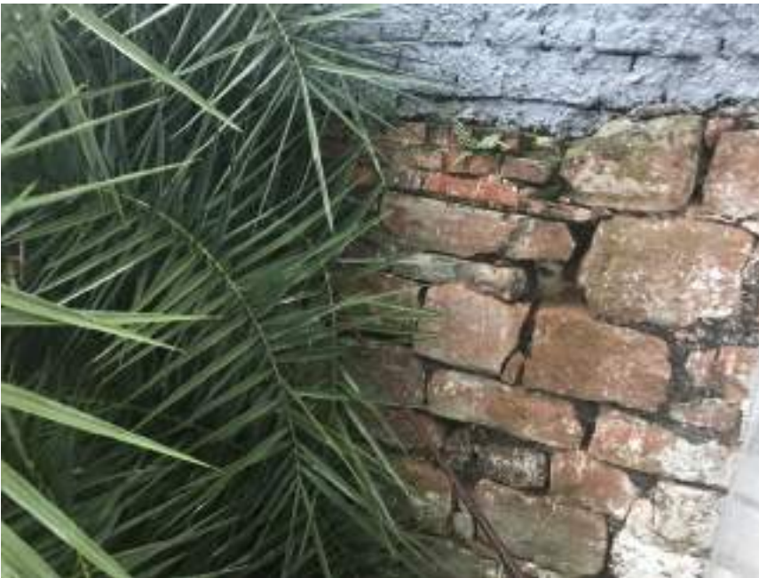
Figura 14 – Fotografia do muro original que compunha a estrutura da casa dos padres
