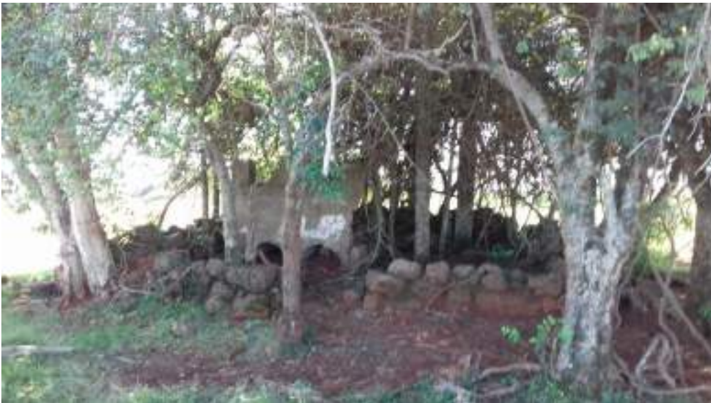
Figura 52 – Estrutura da Capela de São Jeronimo encontrada no interior de São Nicolau
